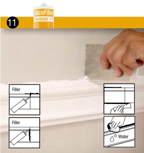
**Verwenden Sie FL300 DecoFiller, um sichtbare Fugen auszubessern** | Wenn Sie kleinere Unregelmäßigkeiten feststellen, können Sie diese mit unserem Fugenfüller FL300 ausgleichen. Möglicherweise fällt dies 24 Stunden nach der Montage leichter.
