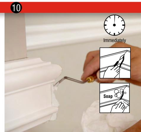
**Säubern** | Überschüssigen Klebstoff innerhalb von 10 Minuten nach dem Auftragen mit einem Malmesser und Seifenlauge entfernen.
