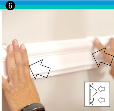
**Fest andrücken** | Bringen Sie das Profil an und achten Sie darauf, dass es waagrecht ist. Wenn Sie sicher sind, dass das Profil richtig positioniert ist, drücken Sie es über die gesamte Länge fest an.
