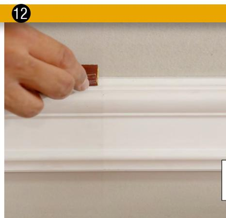
**Für den Anstrich vorbereiten** | Unsere Profile sind bereits werkseitig mit einer weißen Grundierung versehen, müssen dennoch von Ihnen überstrichen werden. Um eine einwandfreie Installation zu gewährleisten, reiben Sie die Leisten der Länge nach leicht mit einem 320 g/m<sup>2</sup>-Papier ab.
